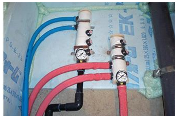
ヘッダー前圧力ゲージの設置
